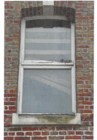
Fenêtre façade cour - Photo : L. Leite
